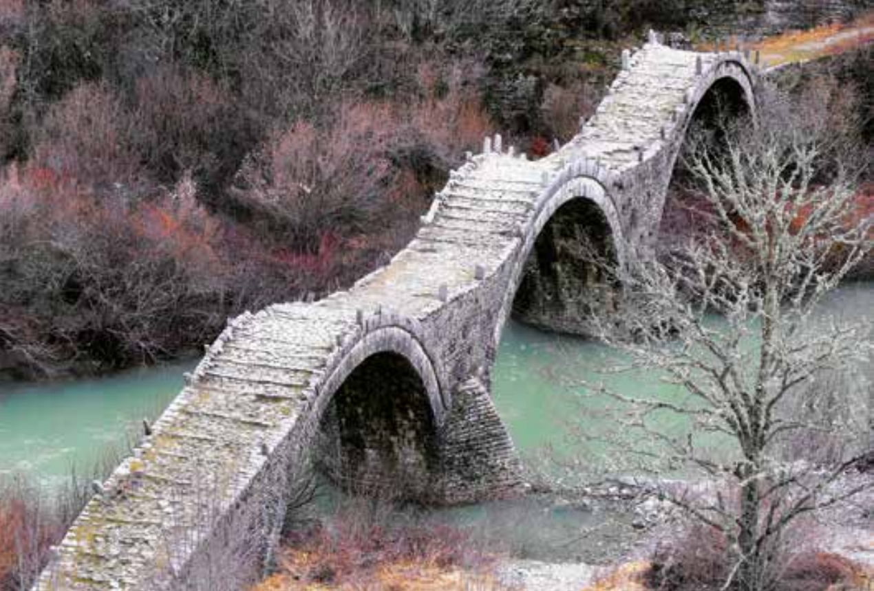
Γεφύρι του Πλακίδα ή Καηλογερίκο (φωτ. Πάνος Καλημέρης)
