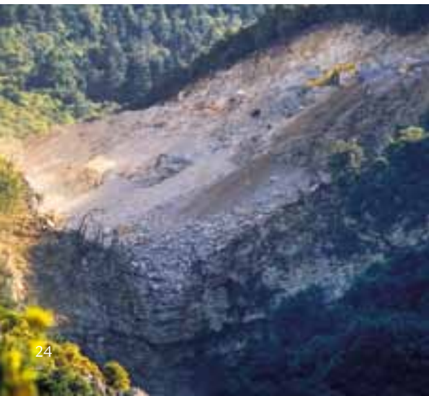
Ζημιές από τις εργασίες στο δρόμο Μενδενίτσας -Ξυλικών
