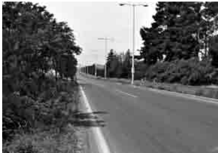
Φυσικά ηχοπετάσματα από πεύκα και θάμνους κατά μήκος ενός κεντρικού αυτοκινητόδρομου
